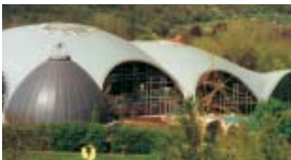
Die Therme Bad Sulza mit türkisfarbener Abdichtung
