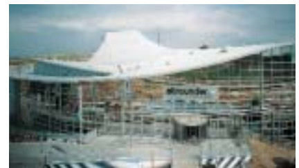
Die Indoor Schneesportanlage Neuss
