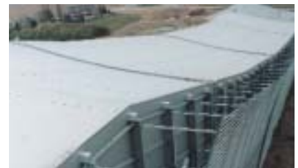
Auch höchste Windbeanspruchung ist optisch ansprechend lösbar
