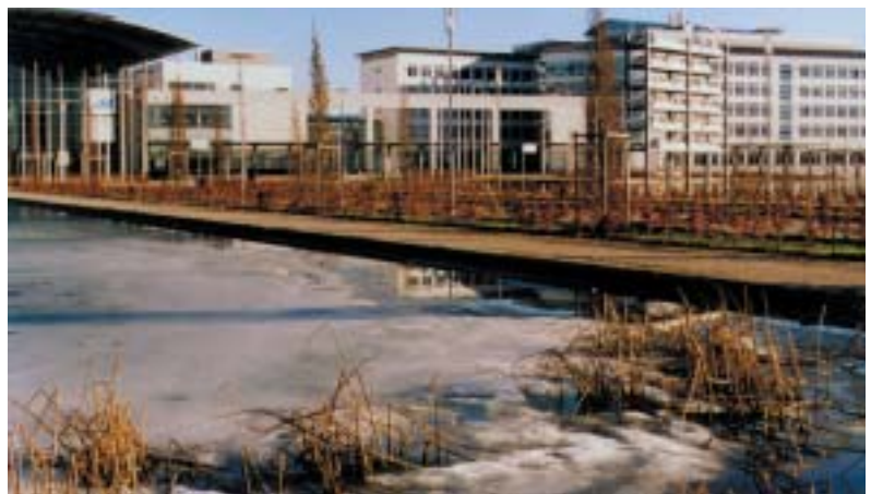
Wurzelschutz mit Kunststoffbahn im „eiskalten“ Teich, Neue Messe München
