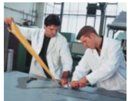
Nahtschließung einer Kunststoff-Dachbahn
