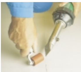
Verschweissung mit handlichem Heißluftgerät
