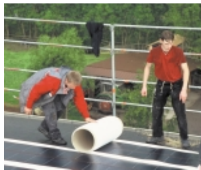
Gewerkeübergreifende Verlegung einer Solardachbahn
