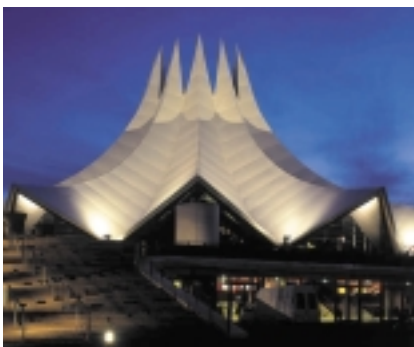
Kreative Dachformen mit Kunststoffbahnen fachgerecht gelöst
