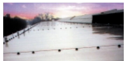
Dachfläche Marinearsenal Wilhelmshaven nach Feierabend
