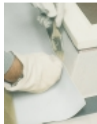
Sichere Ausführung bis ins Detail: Lichtkuppelanschluss mit Kunststoff-Abdichtung
