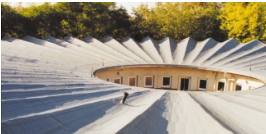
Gelungene Sanierung: komplizierte Abdichtung des Rundbaus der Kita Halle
